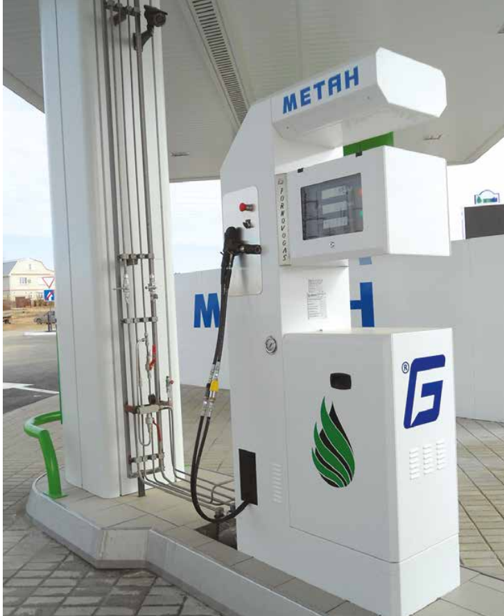
Заправочная колонка на АГНКС в Астрахани. Строительство «под ключ» осуществило ООО «НПК ЛенПромАвтоматика»
