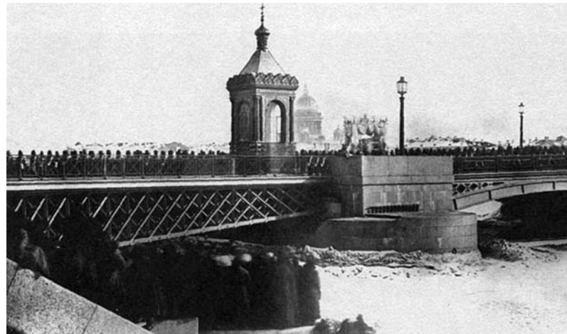
Газовые фонари «Общества столичного освещения» были установлены на мостах, ведущих к Васильевскому острову Санкт-Петербурга (XIX в.)
